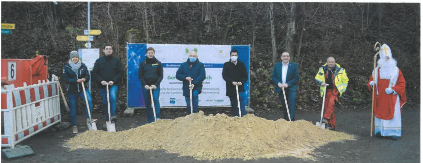
Spatenstich Glasfaserausbau „weiße Flecken“ in Eschach (mit prominentem Gast: Bischof Nikolaus)
